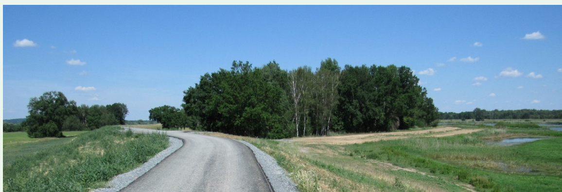
Rys. 23: Odsunięcie wału na terenie Neuzeller Niederung z zachowaniem lasu łągowego w obszarze międzywala, stara trasa wału (na prawo od granicy lasu) i nowa trasa wału (droga asfaltowa)
