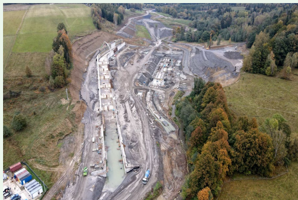
Rys. 18: Budowa zbiornika w miejscowości Boboszów
