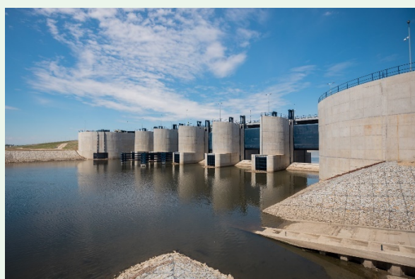
Rys. 16: Zbiornik przeciwpowodziowy Racibórz Dolny, budowla przelewowo-spustowa, widok na zasuwę
