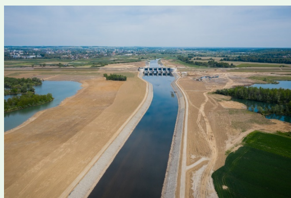
Rys. 17: Zbiornik przeciwpowodziowy Racibórz Dolny, koryto rzeki Odry, prowadzące do budowli przelewowo-spustowej
