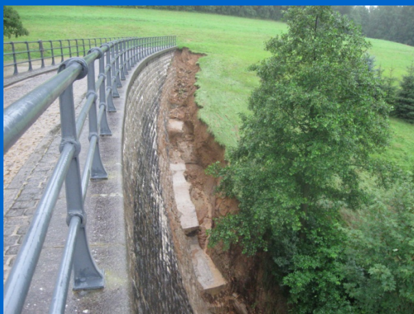
Mlýnice wkrótce po kulminacji powodzi (7.8. 14:00)
